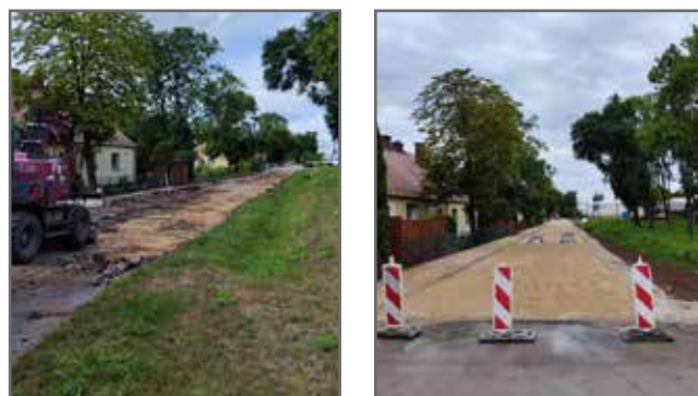
Początkowa i końcowa faza przebudowy drogi gminnej w Niezychowicach
