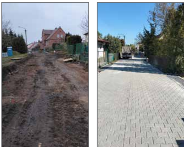
Budowa ul. Wiejskiej i Krótkiej w Chojniczkach
