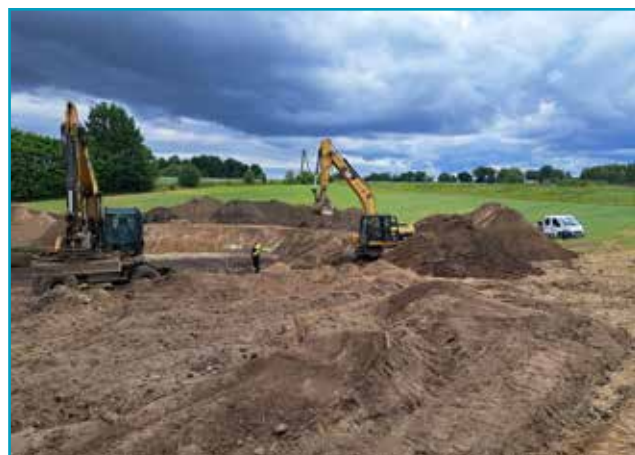
Rozbudowa zbiornika retencyjnego w miejscowości Klawkowo
