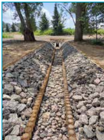
Wylot kanalizacji deszczowej do Brdy w Swornegacich
