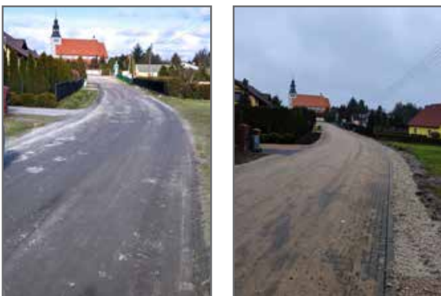
Ul. Mańkowskiego w Nowej Cerkwii przed i po budowie
