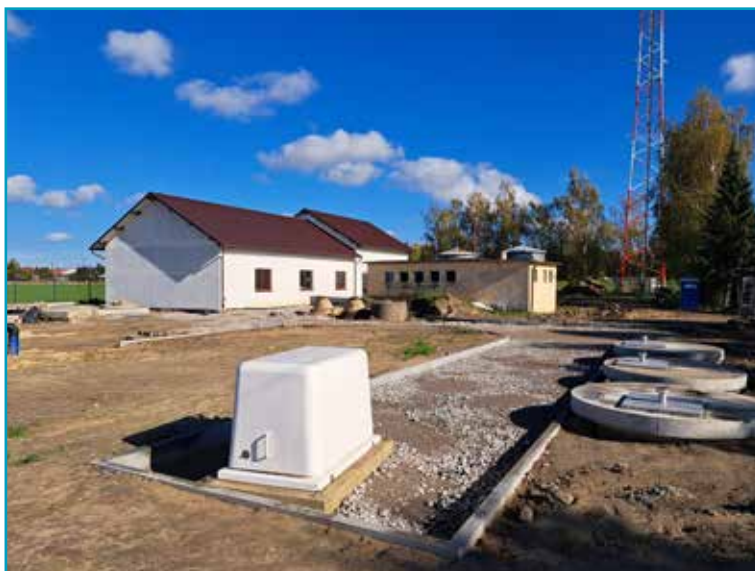
SUW Ogorzeliny: nowy budynek, studnia głębinowa i odstożniki popłuczyn
